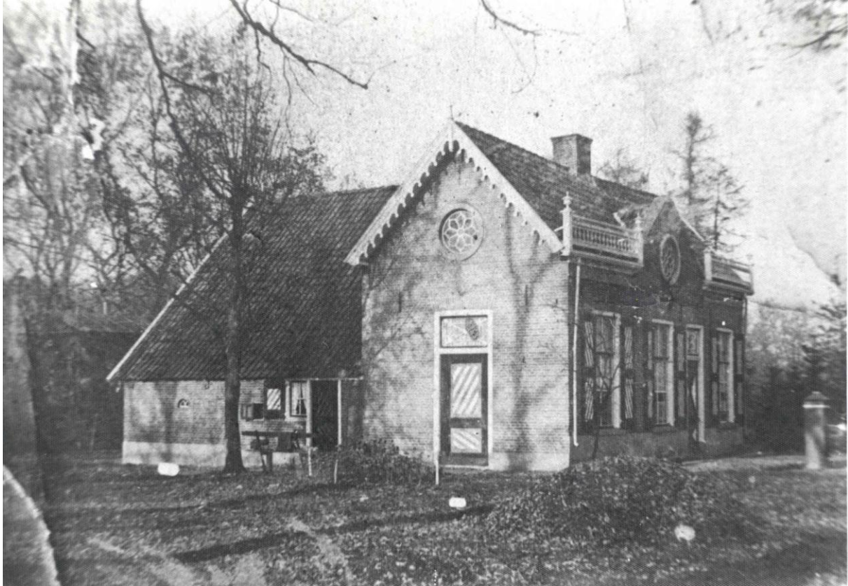
Jachthuis ca. 1925. De roosvensters in de topgevel en in het fronton in de voorgevel zijn gegoten door ijzergieterij Nering Bögels te Deventer. Voor de balustrade heeft Derk baron Bentinck 32,50 gulden betaald aan dezelfde firma. Voor de deur is de pomp nog aanwezig. Origineel was in bezit van Heintje Marsman. Foto W. Hoogeland.
