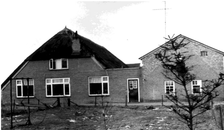
Het Nieuwe Huis, staande aan de Kreilemansweg 6 te Heeten, gebouwd in 1858 in opdracht van Willem Overmars. Foto: Dr. J.J.Reinking, ca 1967, Coll. W. Hoogeland.
